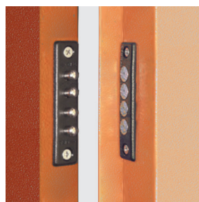
Contatti elettrici tra anta e telaio
